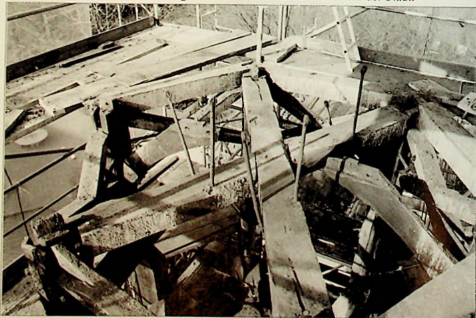
Schäden am Dachreiter und Glockenstuhl (oben)
